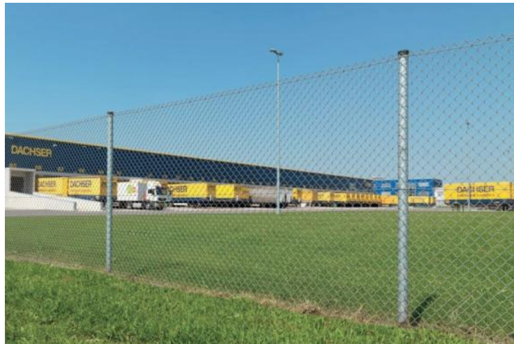
Hekwerk: gaashekwerk Heras 'Orses' 2 m hoog.
